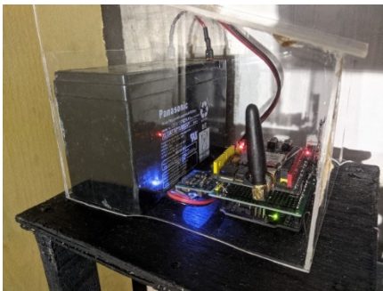
Gbr 4. Alat Prototype yang telah terpasang
